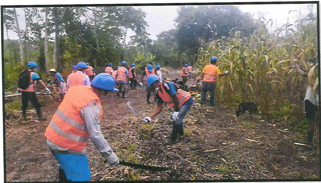
**Figura 014.** Vista del residente de obra, donde se observa trabajos de limpieza de terreno.
