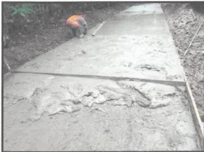
Figura 014. Vista del residente de obra, donde trabajos de vaceo de mortero  $f_c=175 \text{ kg/cm}^2$ .
