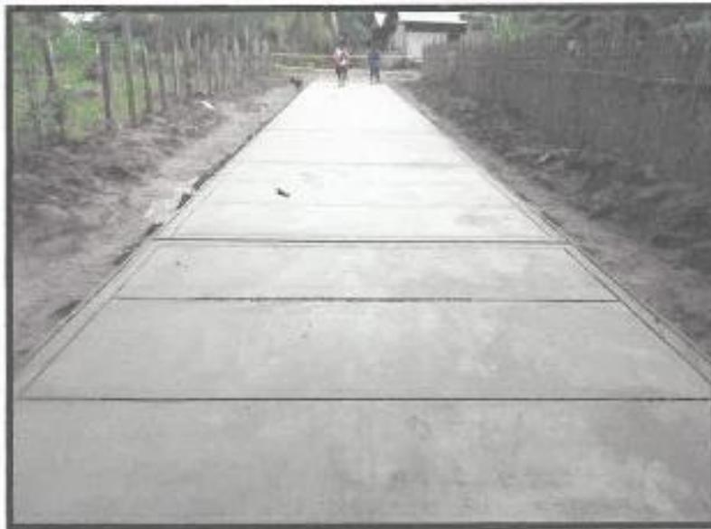
Figura 011. Vista del residente de obra, donde se observa trabajos de bruñado en veredas
