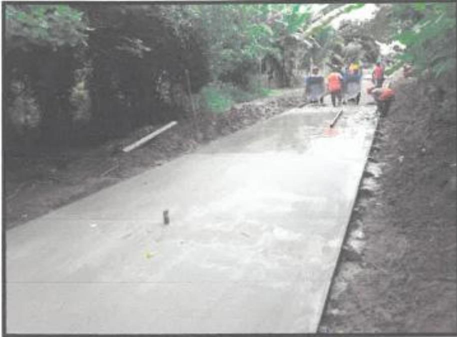
Figura 013. Vista del residente de obra, donde se observa trabajos de curado al mortero.
