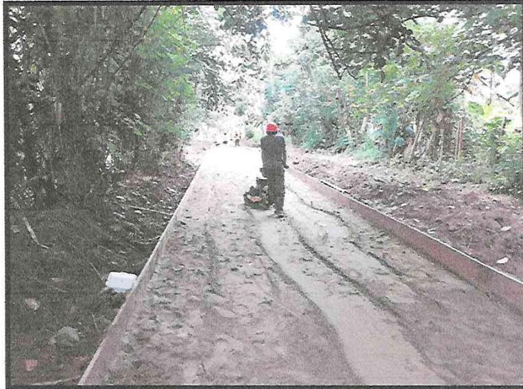
PANEL FOTOGRAFICO 003. Vista del residente de obra, donde se observa trabajos nivelación y apisonado con plancha compactadora.
