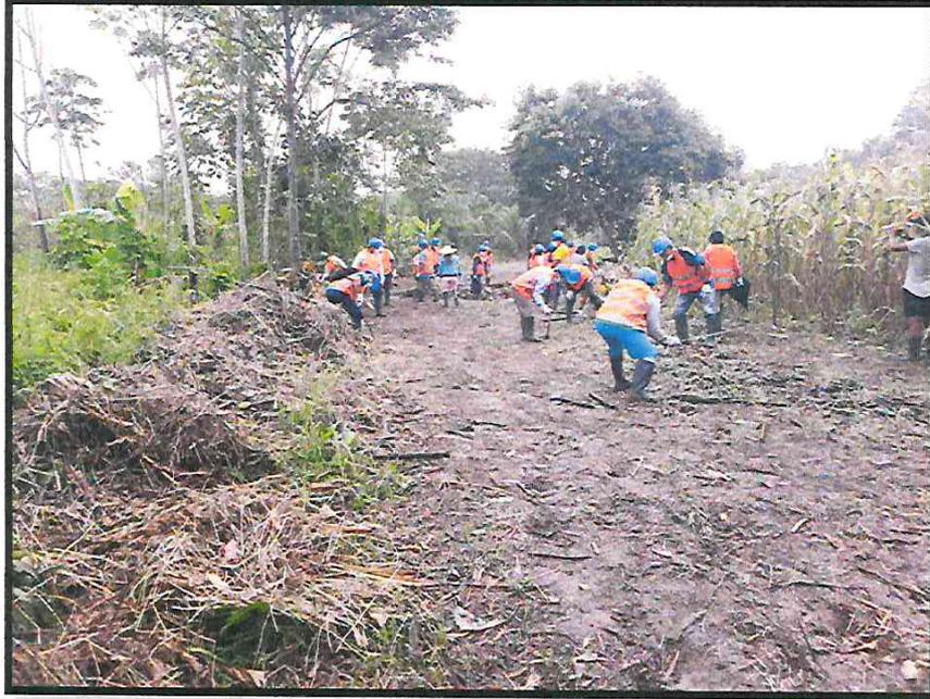
Figura 009. Vista del residente de obra, donde se observa trabajos de limpieza y descroce del terreno.
