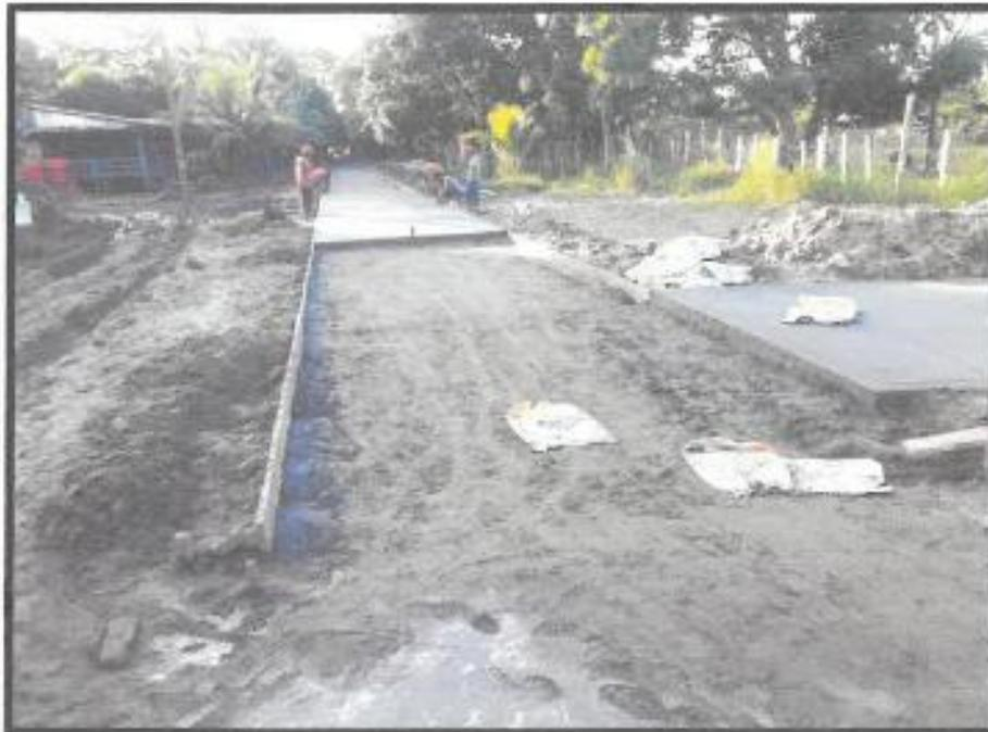
**Figura 010.** Otra Vista del residente de obra, donde se observa trabajos de mortero,  $f_c = 175 \text{kg/cm}^2$
